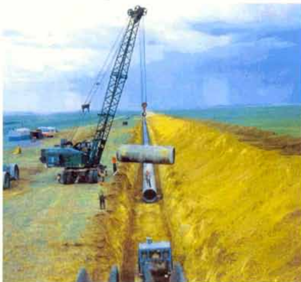
Строительство оросительного трубопровода в Саратовской области
