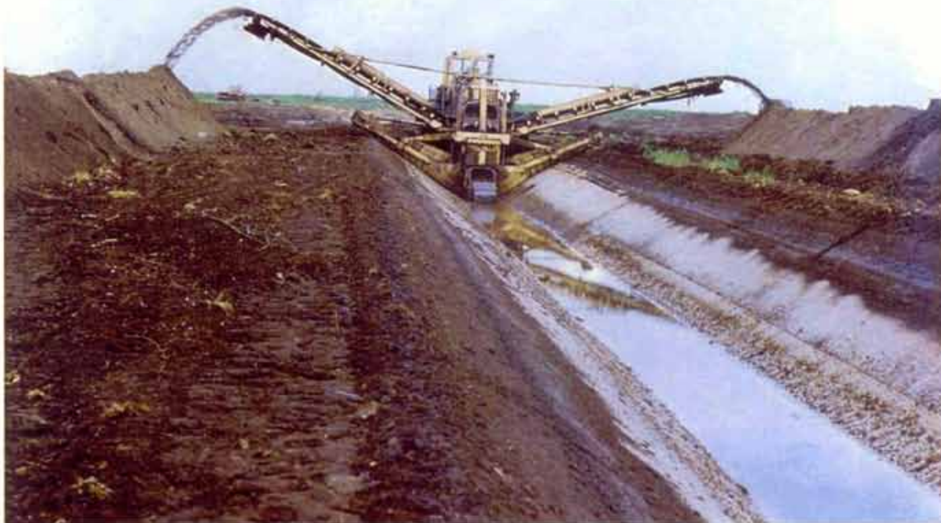
Строительство канала в Саратовской области Canal construction in the Saratov Region
